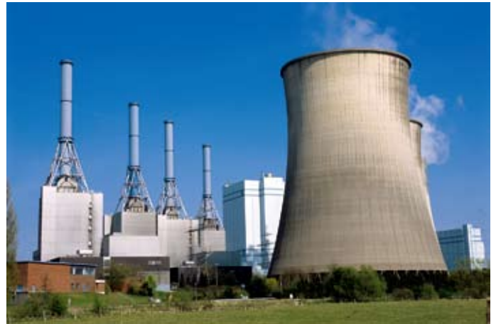
Kraftwerke sind nicht nur durch Zäune gut geschützt, sondern auch durch virtuelle Maßnahmen.
